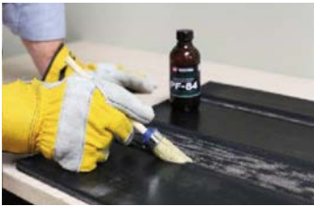
3. Preparação com Primer específico PF-84
