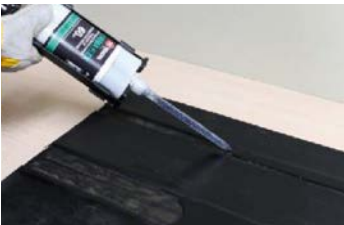
6. Aplicar material de reparo Permaflex
