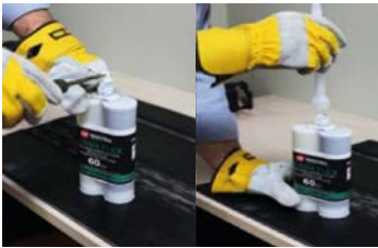
4. Remover a vedação e prender a cânula de mistura
